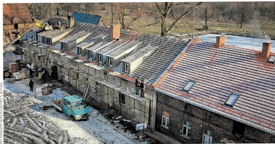
Od dwóch lat gruntowny remont schroniska w Żukowicach prowadzi diecezjalna Caritas
